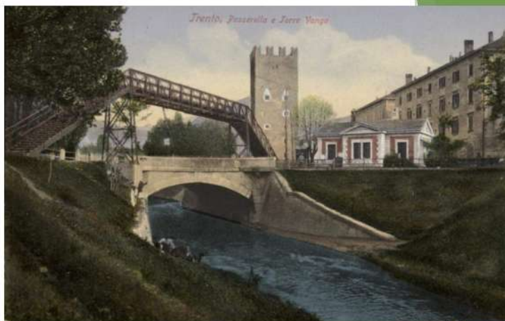
Ponte sull'Adigetto, 1913. Lehrburger, Biblioteca digitale trentina
